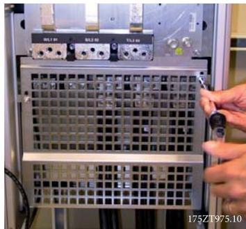
Рисунок 4.15: Монтаж экрана ЭМС.
