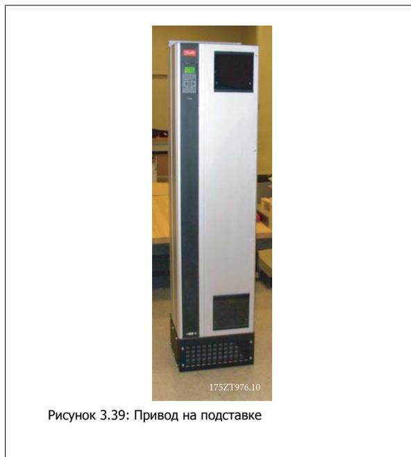
Рисунок 3.39: Привод на подставке
