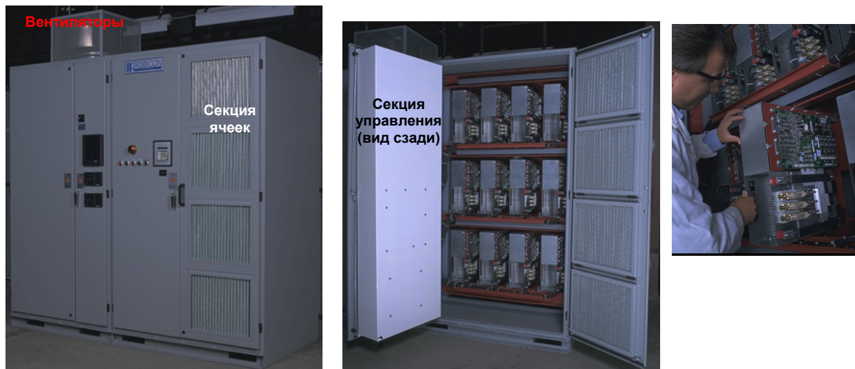
Рисунок 2-10. Секция ячеек (типичная) модели GEN III привода Perfect Harmony
