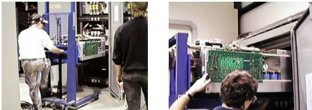
Рис. 7-8. Установка/удаление ячейки с помощью вилочного подъемного устройства
