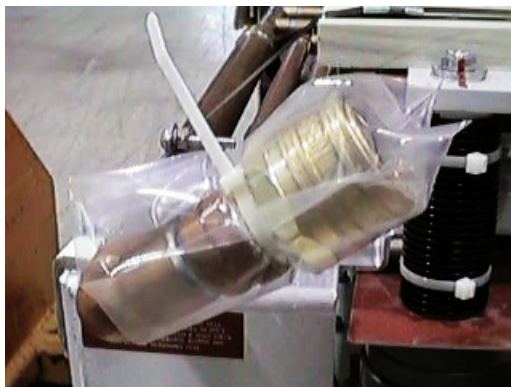
Рис. 7-7. Предохранение открытого соединителя ячейки с помощью полиэтиленового пакета и проволоочной обвязки
